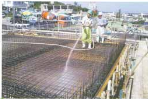
2 鉄筋・鉄骨へのEM散布
