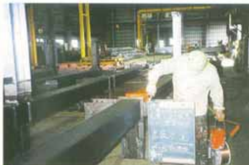
3 鉄骨の錆び止め塗料
